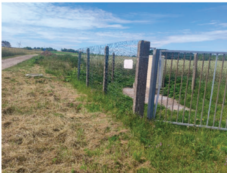
Le poste de relevage
